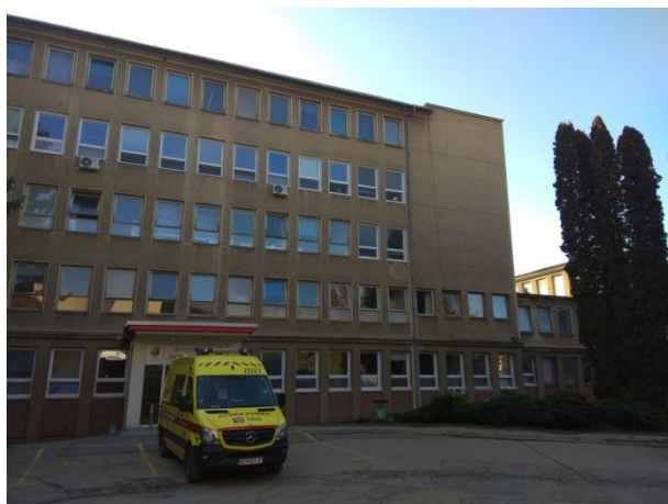
Obr. č. 4. Časť objektu č. 3 Prijem
