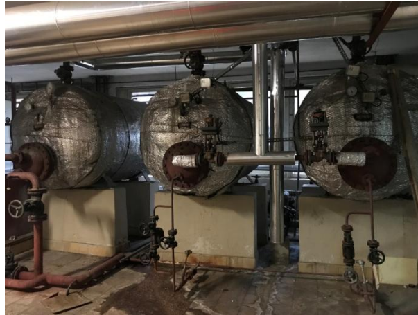
Obr. č. 11. Zásobníkové ohrievače TUV vo VS.
