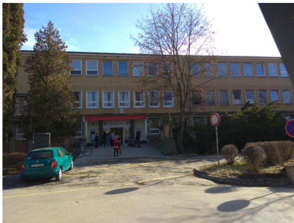
Obr. č. 3. Časť objektu č. 2 Blok B
