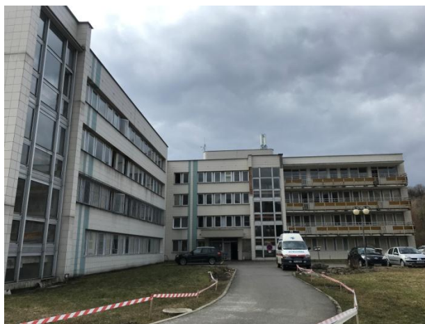
Obr. č. 8. Časť objektu č. 7 LDCH
