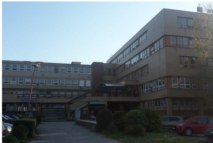
Obr. č. 1. Celkový pohľad na NsP
