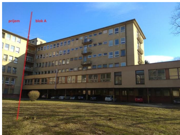
Obr. č. 2. Časť objektu č. 1 Blok A
