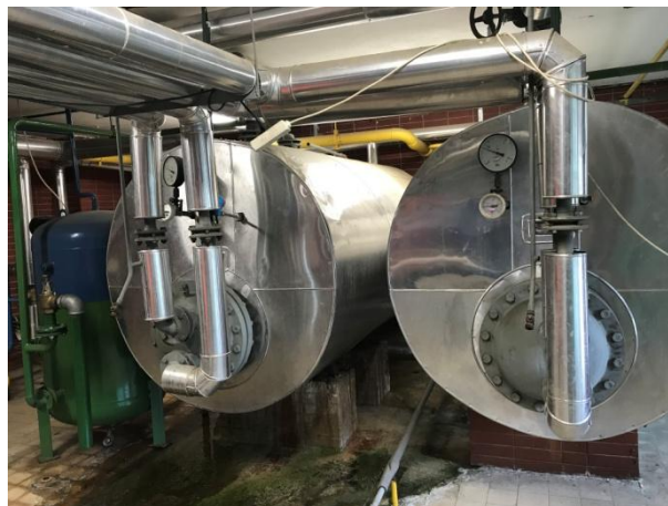
Obr. č. 14. Zásobníkové ohrievače TUV.
