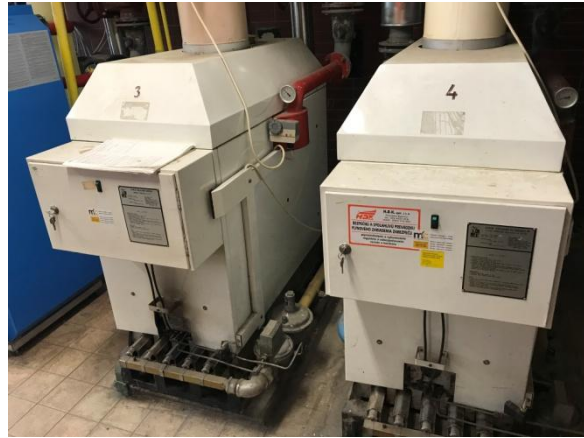
Obr. č. 13. Nízkotlakové kotly AKG.
